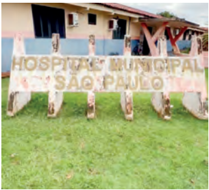
Prédio antes da reforma
