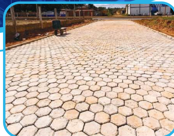
Construção da Pavimentação Asfáltica em Bloquete na Rua Edson Vaz Vieira
