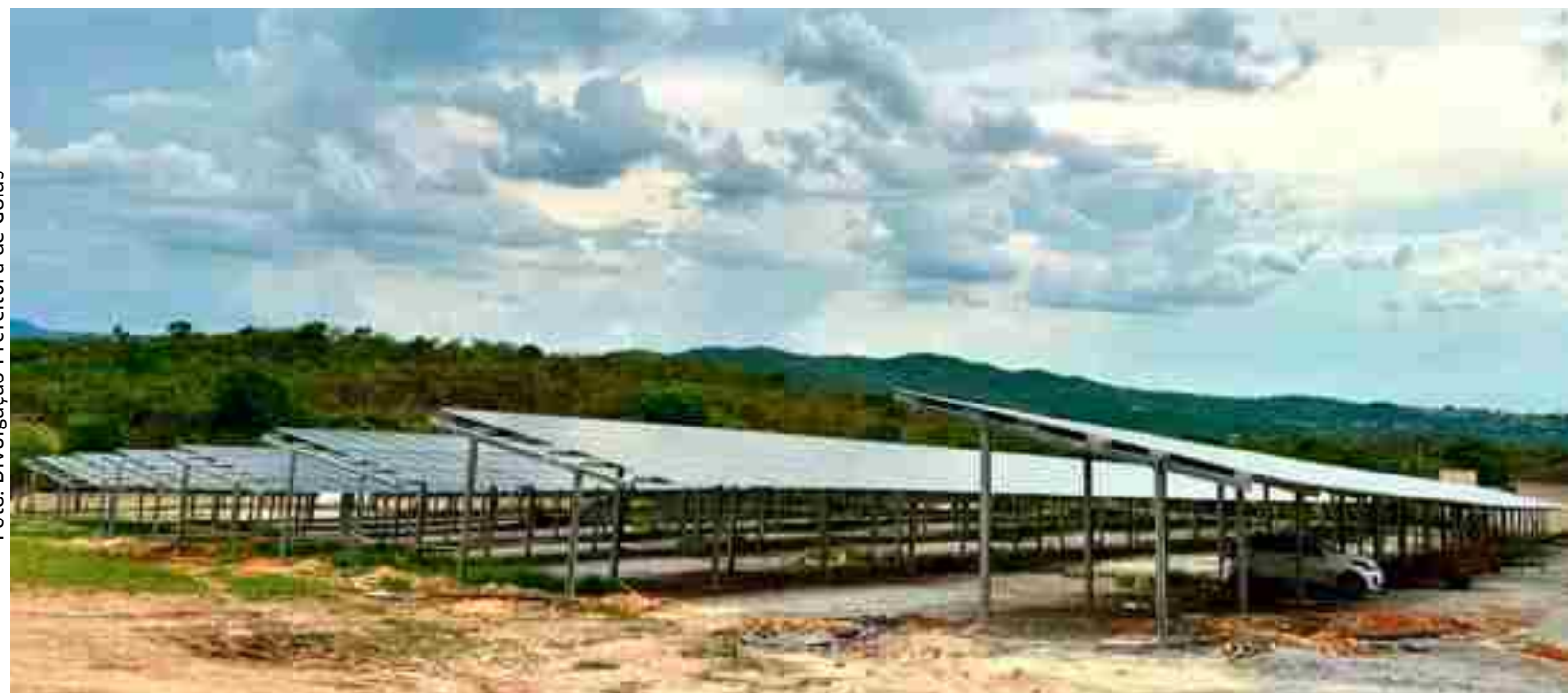
Usina fotovoltaica está sendo instalada no Setor Bacalhau, no Município de Goiás
