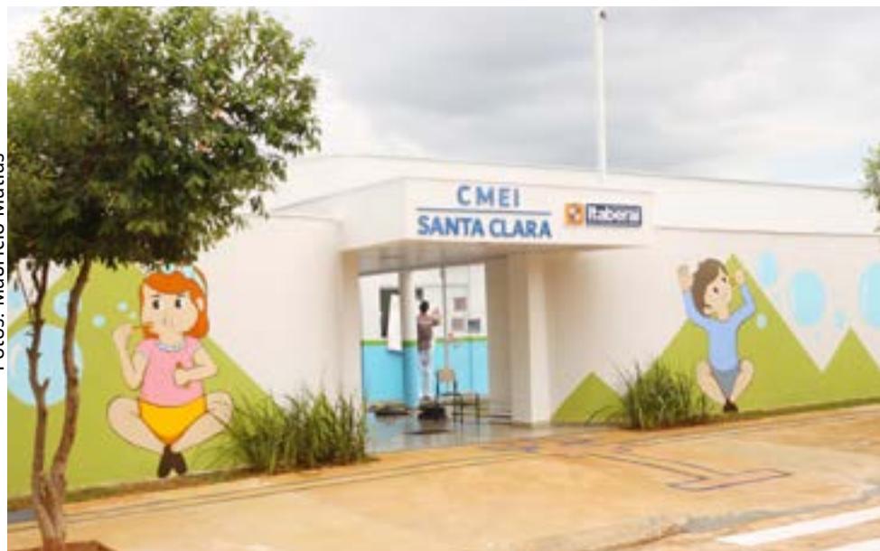
CMEI Santa Clara passou por reforma, ampliação e revitalização
