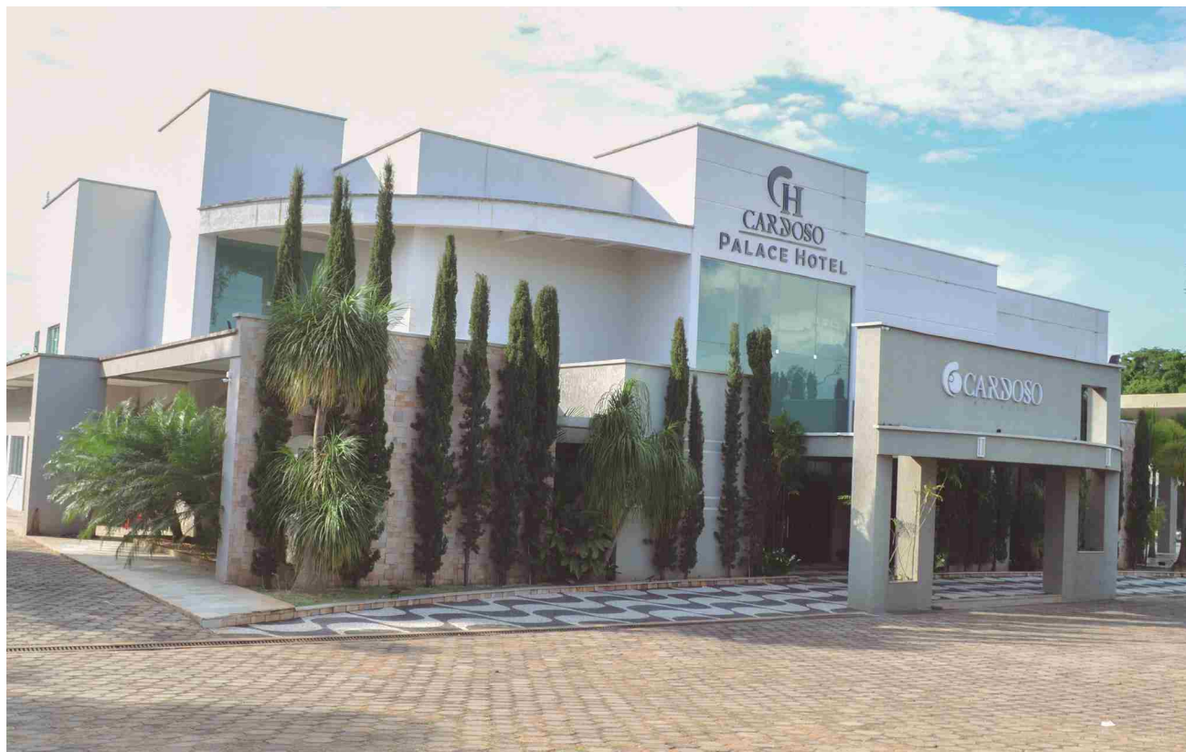
O Cardoso Palace Hotel está situado na Rodovia BR-070, saída para Itaguari
