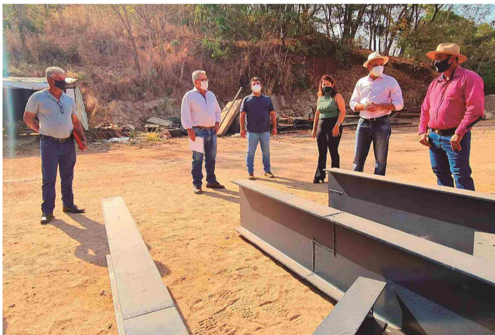
A parte estrutural da ponte já está no canteiro de obras
