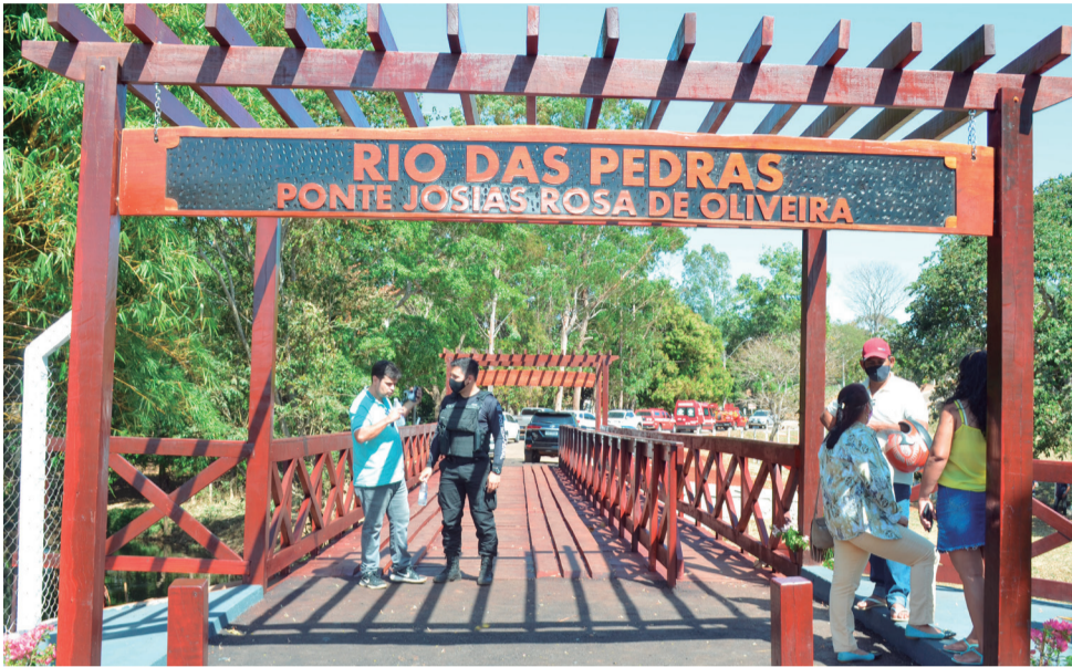
Ponte Josias Rosa de Oliveira, conhecida como Ponte Velha, no Rio das Pedras
