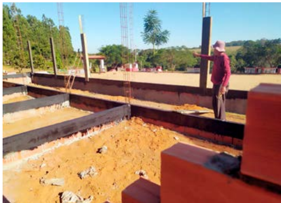
Construção de anexo no CEC já está em andamento
