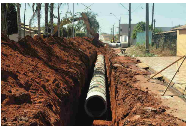
Construção de galerias pluviais nas avenidas Tocantins e Araguaia, e no Conjunto Dona Francisca
