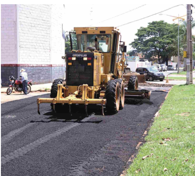
Recapamento da Avenida Tocantins
