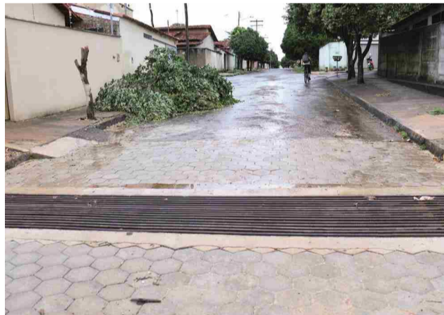
Construção de drenagem de superfície da Rua 39
