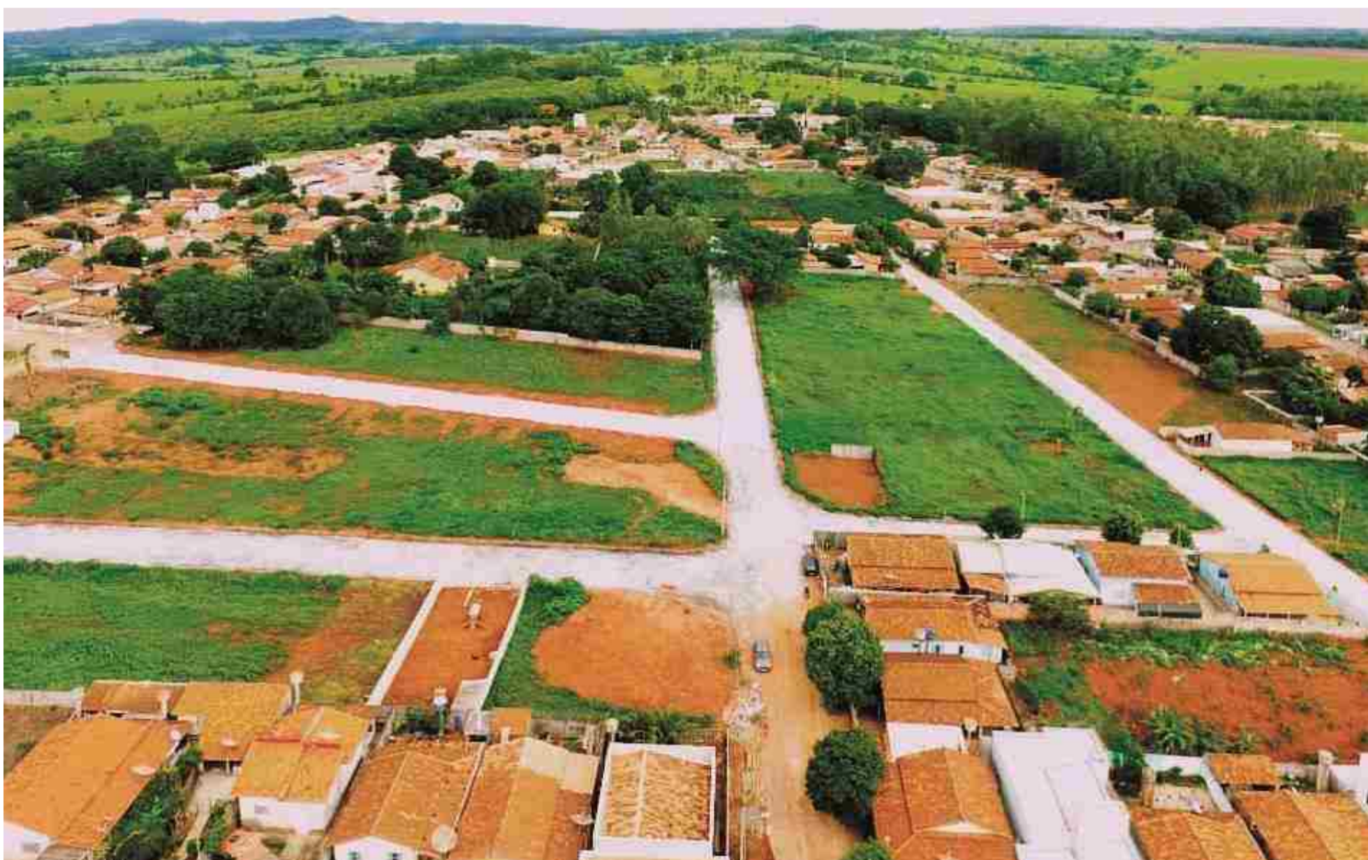
Regularização Fundiária implantada nos setores Novo Horizonte, Conde dos Arcos, Residencial Menezes, Menezes Extensão e Diolândia
