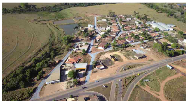
Pavimentação do Setor Lara Park - 13 mil m 2 de asfalto
